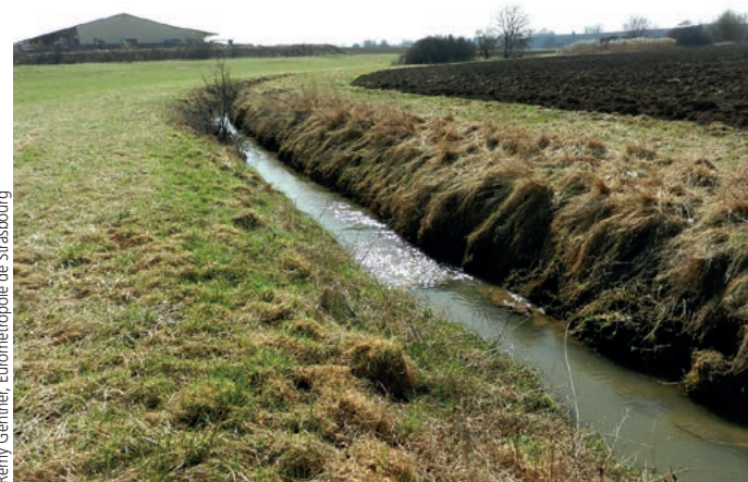
Le Neubaechel avant travaux en 2012.
