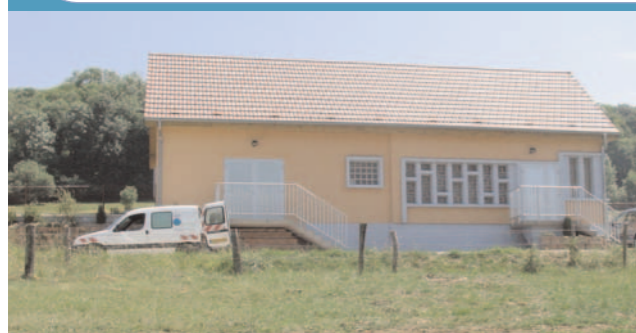
Traitement, SIAEP des Ableuvenettes (88)
