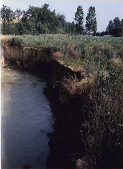
isme de dégradation.
