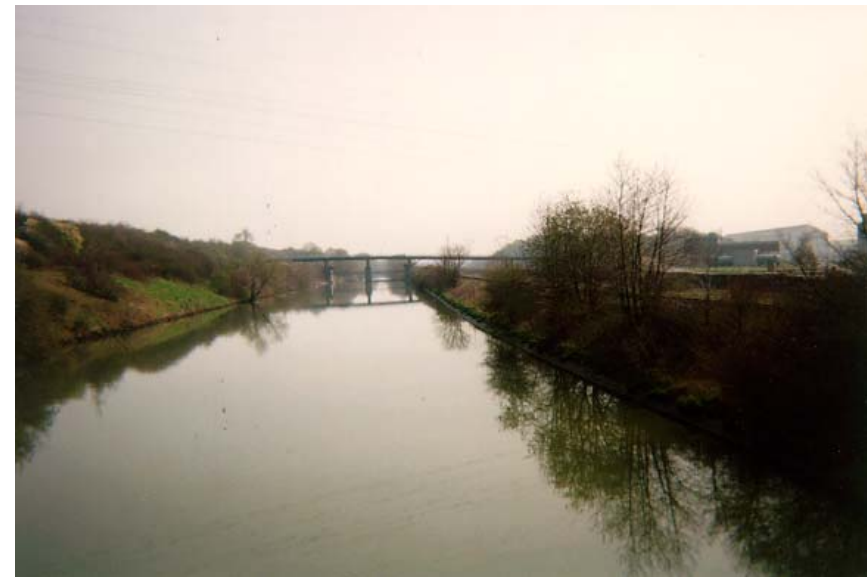
d : partie aval en zone urbaine et industrielle (aval de Joeuf) photographie Atelier des territoires : 23a : Gandrange, mars 99
