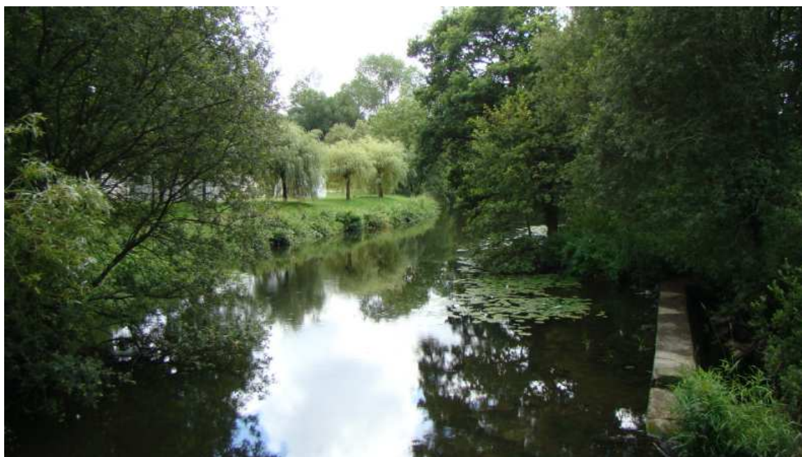
Prise d'eau du Moulin Bescond sur le Leff (C.C. Paimpol-Goëlo), Lanleff -22
