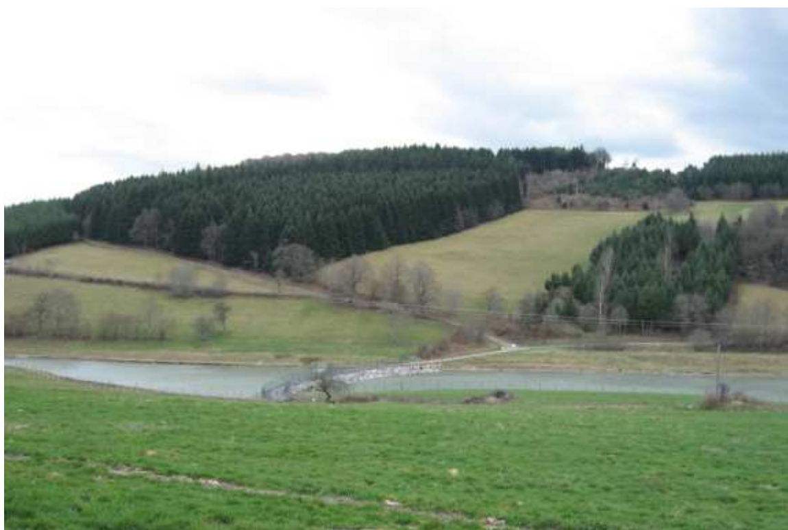
Barrage des Echansieux, SIE du Gantet, Violay - 42
