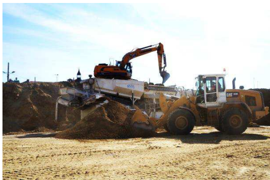
Unité de traitement en fonctionnement
