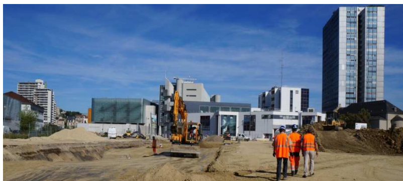
Chantier ZAC Grand Cœur à proximité du Palais des Congrès
