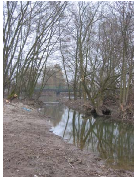
Entrée du bras après travaux
