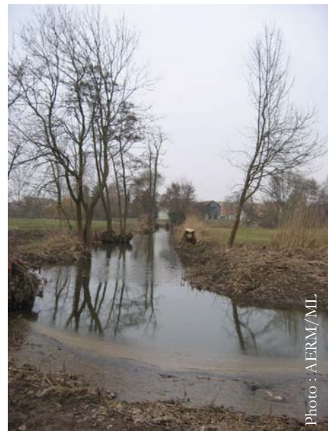
Chenal après travaux
