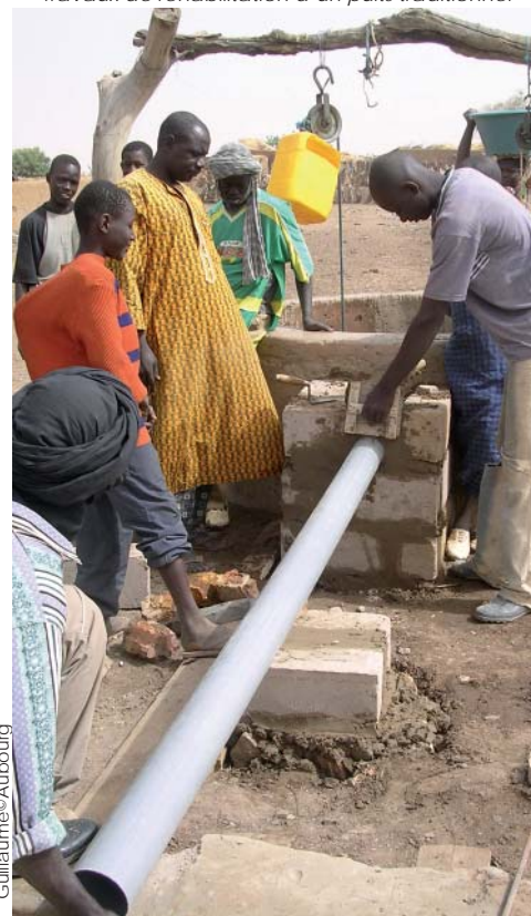
Travaux de réhabilitation d'un puits traditionnel
