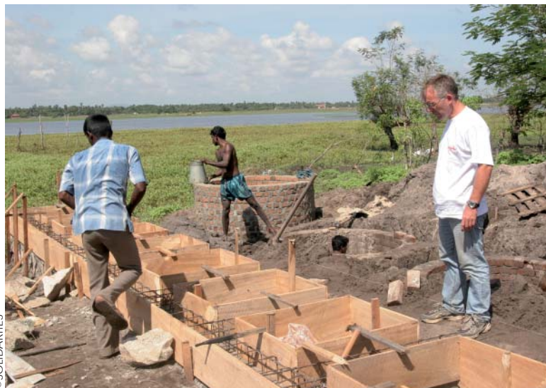
Réalisation de latrines au Sri Lanka
