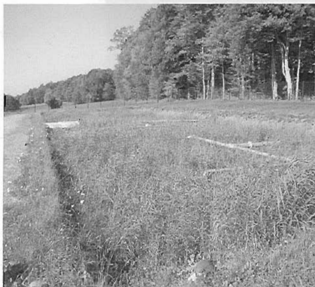
Le premier étage de traitement On distingue les rampes d'alimentation en inox.
