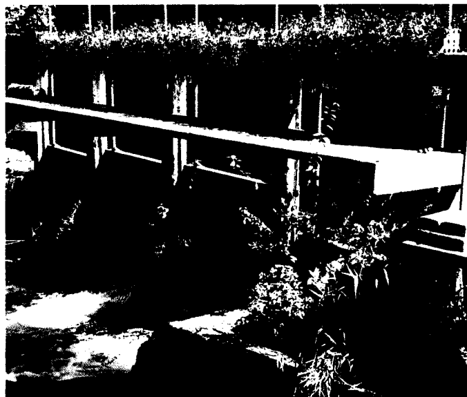
Barrage entravant la circulation des poissons migrateurs : jet sous vannes, vitesse d'écoulement rapide, turbulences.
