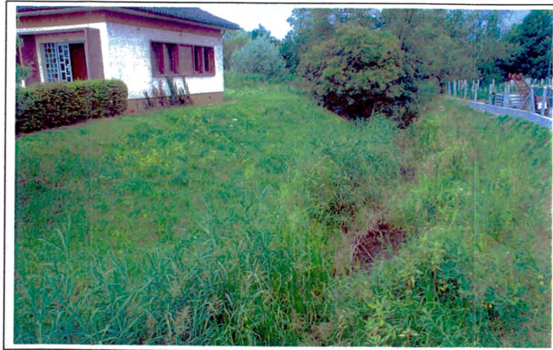
Amont du pont de la R.D.28 : même si un envahissement du chenal est ici à déplorer, le milieu est bien plus favorable qu'avant les travaux, notamment grâce à la banquette créée en rive droite (à gauche sur la photo).
