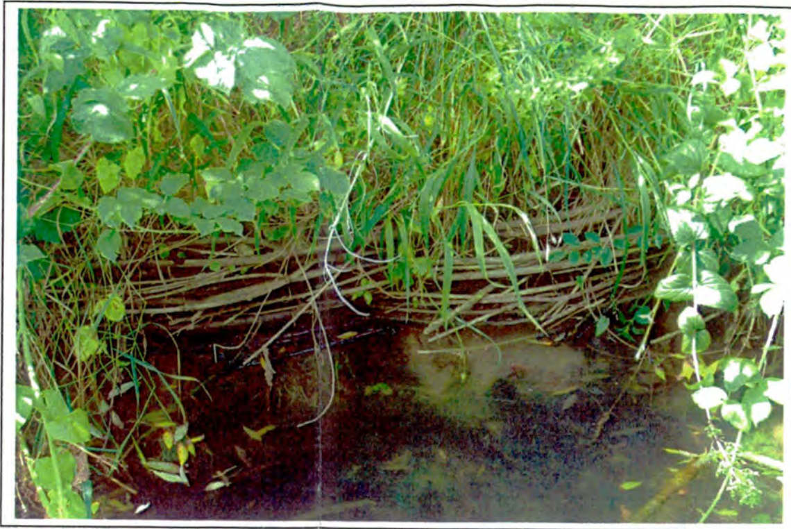
Détail de la fascine implanté en aval du pont de la R.D 28 : l'ouvrage, en remarquable état, constitue un abri sous-berge de qualité pour la faune piscicole.
