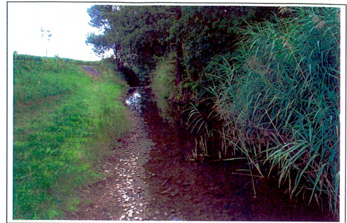
« Zone d'accès à l'eau » constitué après retalutage de la berge traitement du talus et du haut de berge avec plantations et aménagement d'une « plage » de galet, en pied de berge.
