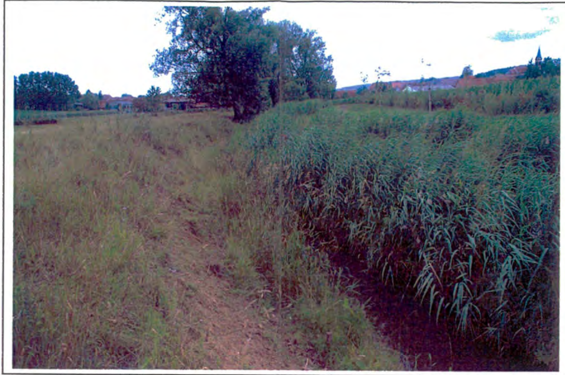
En aval de la passerelle : le talus est presque à nu, suite à des piétinements. Il est vulnérable et devra être protégé par un géotextile, semencé et enfin bouturé. Une plantation d'arbres de haut-jet permettra également d'atténuer l'éclairement.
