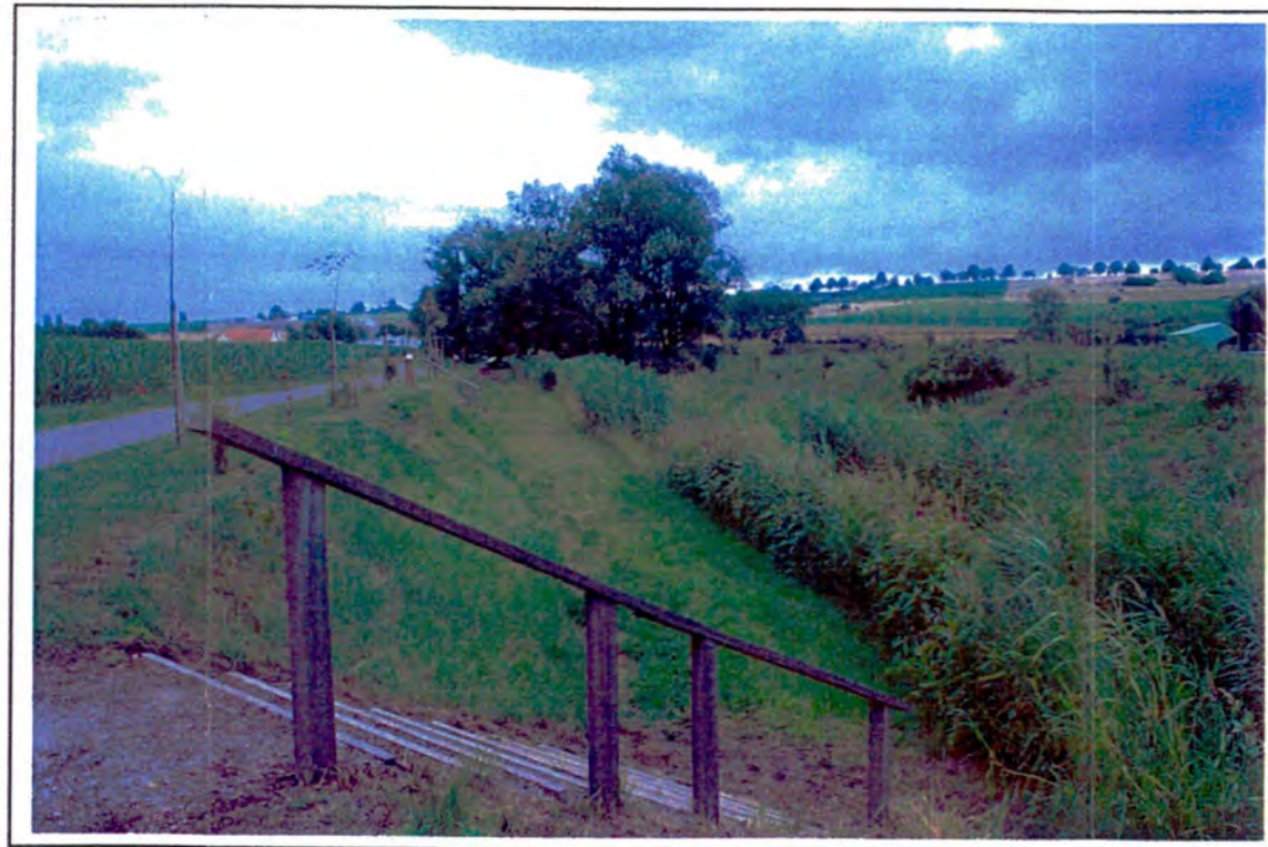
Aménagement d'une « banquette » avec fascine d'hélophytes en pied et plantations sur talus et haut de berge.
