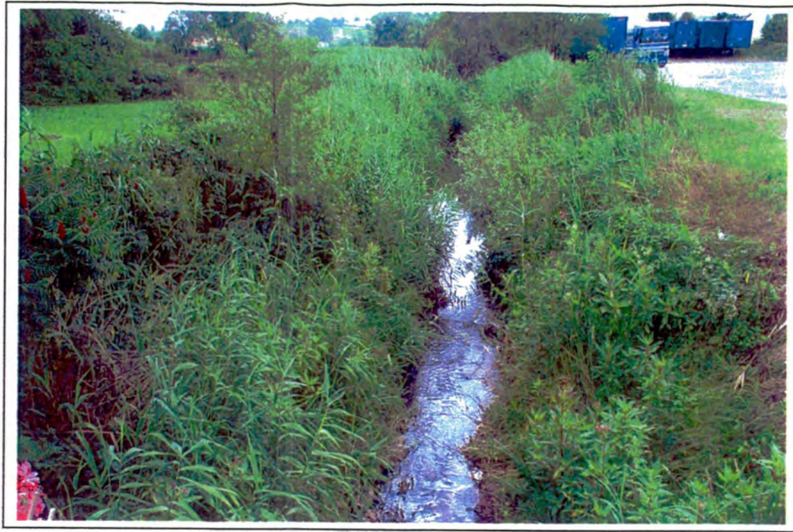
Lit mineur d'étiage constitué à partir des blocs présents sur la berge, végétalisés avec des plantations d'hélophytes.
