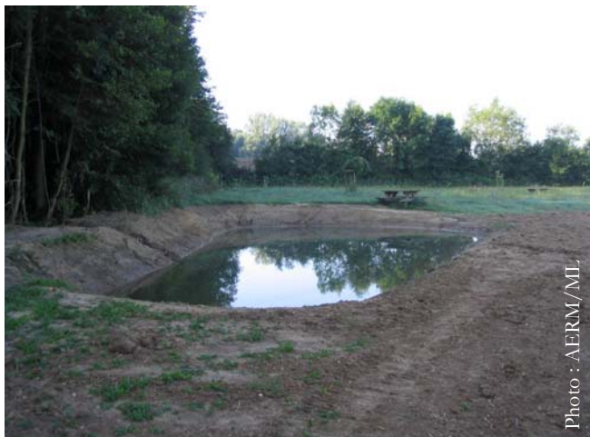
Mare créée avant l'arrivée du ruisseau dans l'étang (juste après travaux)
