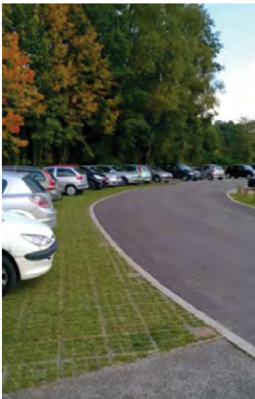
↓ Parking en dalles enherbées
