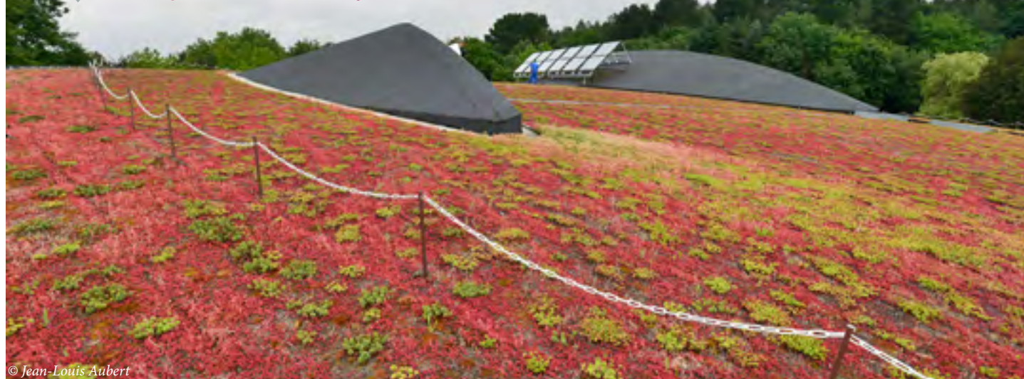
↓ Toiture végétalisée, Piscine des Gayeulles, Rennes
