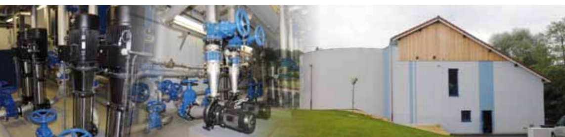
Station d'alimentation en eau potable de Barst
