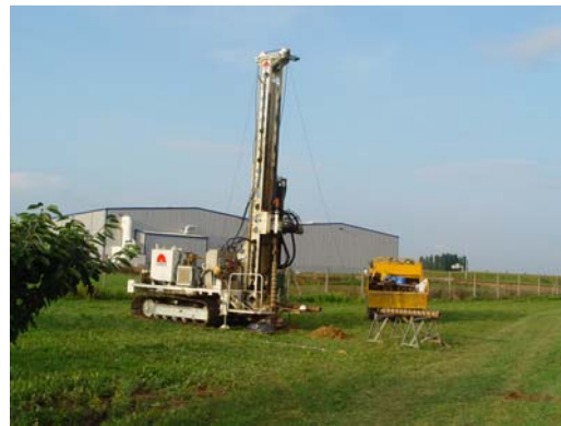
Illustration 10 : vue d'ensemble du matériel de carottage (ici sur V95)
