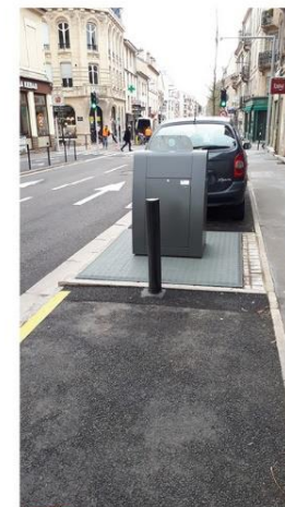
Un conteneur enterré
