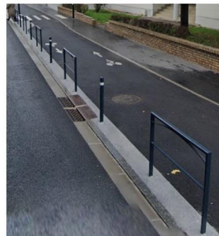
Délimitation PCB/chaussée avec barrières+potelets et résine de couleur grise
