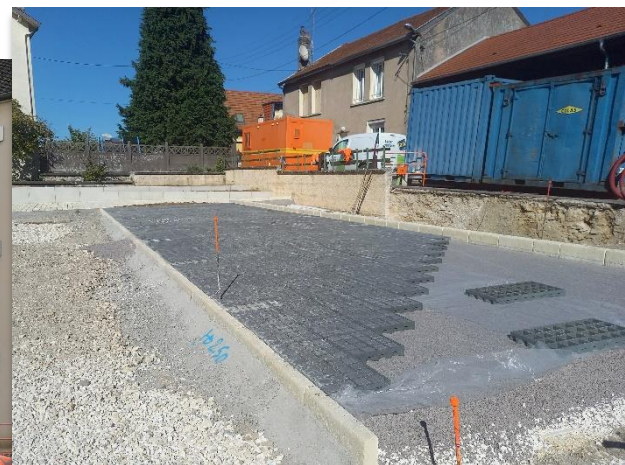
mise en œuvre de la résine drainante
