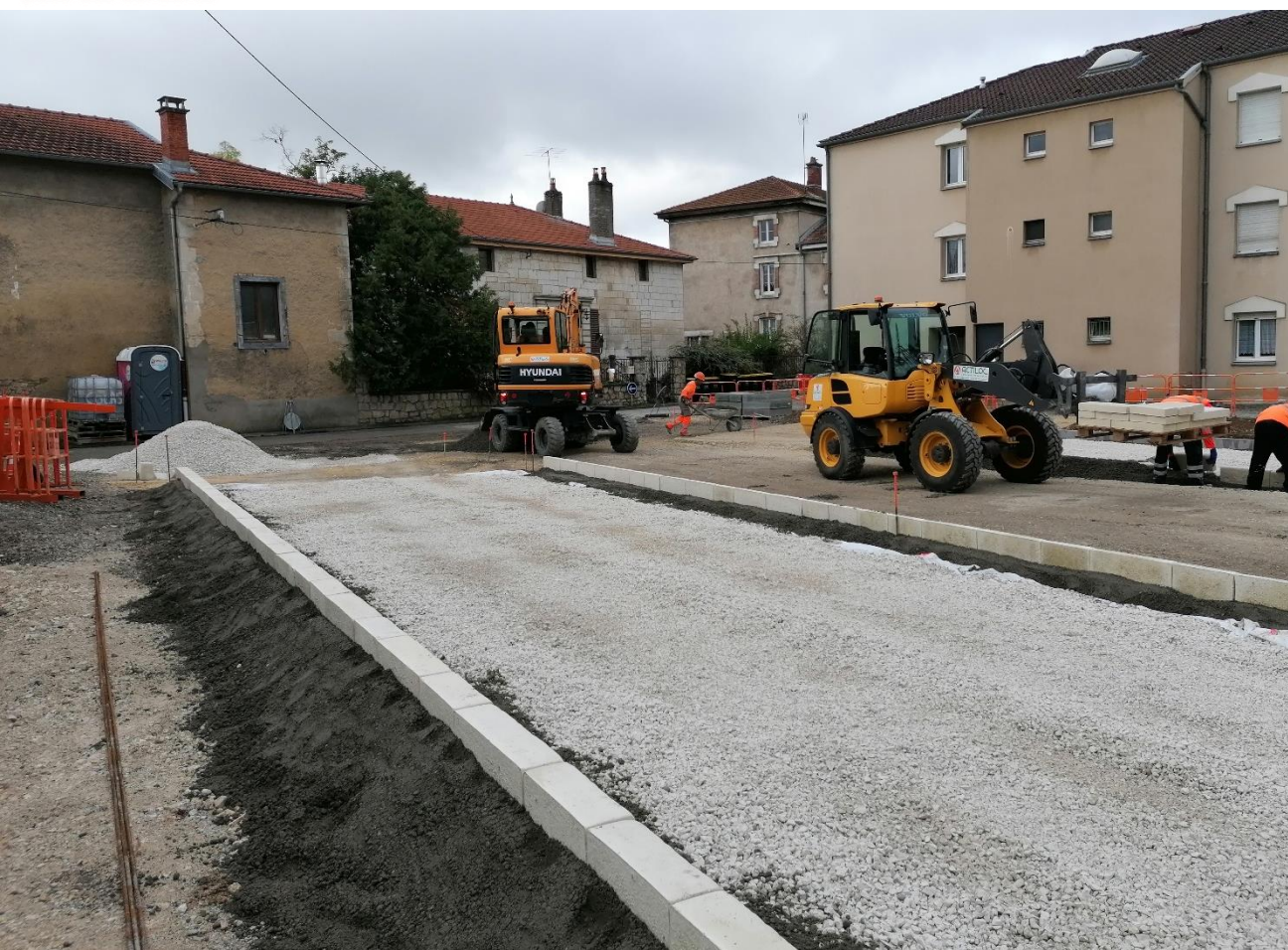
pose des bordures
