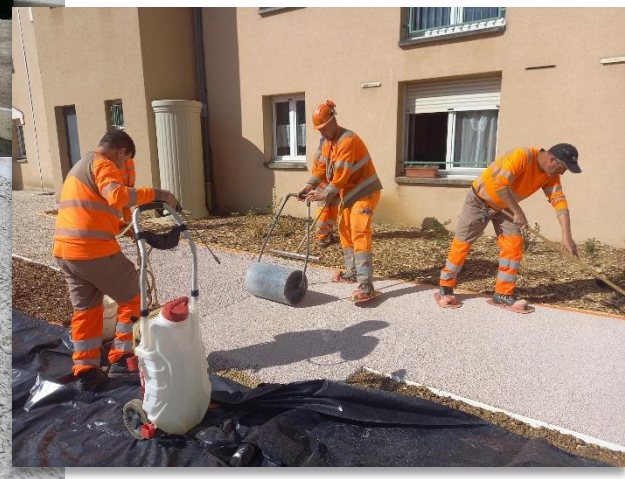
mise en œuvre de la résine drainante
