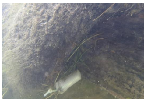
Figure 2 : Sonde thermique installée.
