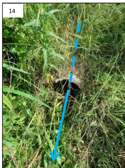
Figure 36 : Sortie de drain agricole sur la zone d'étude (Source : Photos 02/05/2019)
