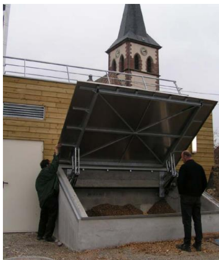
Figure 69 : Silo de la chaufferie d'Ammertzwiler (Source Chambre d'Agriculture d'Alsace)
