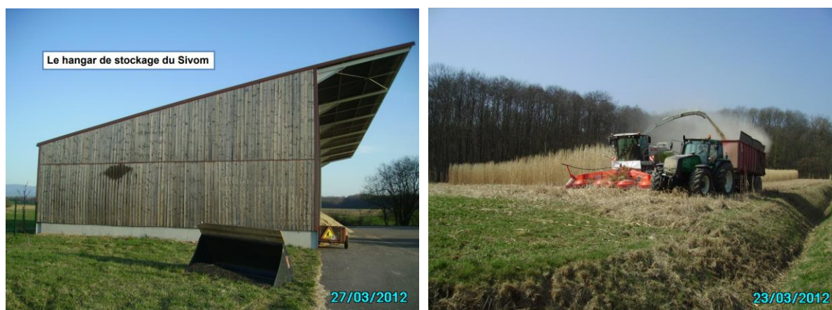
Figure 71 : Hangar de stockage et récolte de miscanthus pour les chaufferies du Sivom Ammertzwiller et de Bernwiller (Agence de l'Eau Rhin Meuse, 2012)
