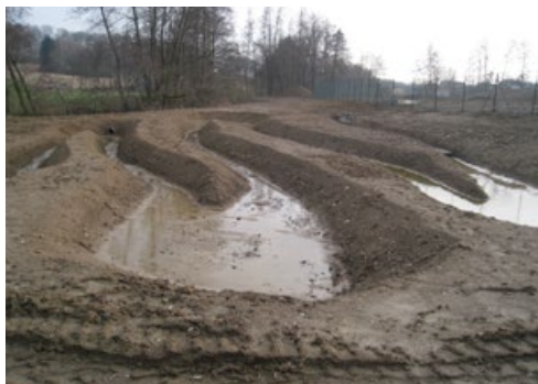
Accès trop étroit pour permettre le passage d'engins
