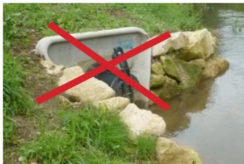
Mauvais exemple de rejet en berge
