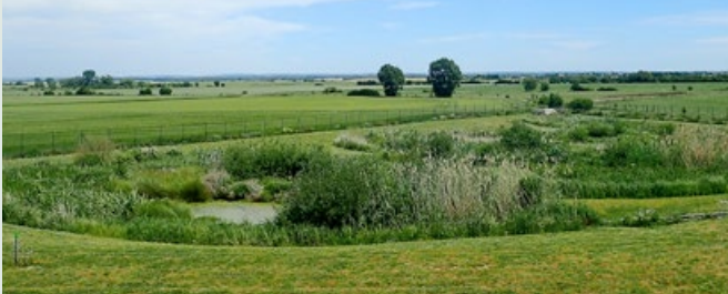
ZRV de type mare et noue à Hannonville-sous-les-Côtes (55)
