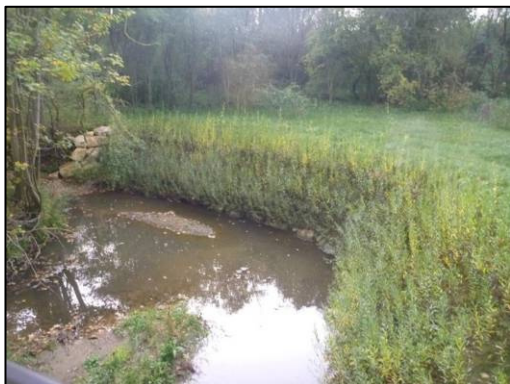
Protection de berge végétalisée, un an après réalisation
