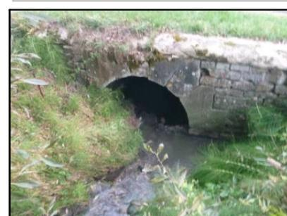
Comblement partiel de l'ouvrage de franchissement de la RD 65a, diminution de la capacité hydraulique de l'ouvrage
