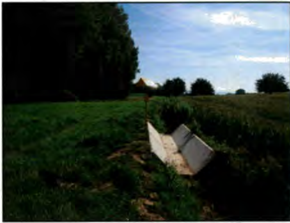
Fossé périphérique F2 avec protection en béton de la conduite de gaz GRT (26/06/2015)
