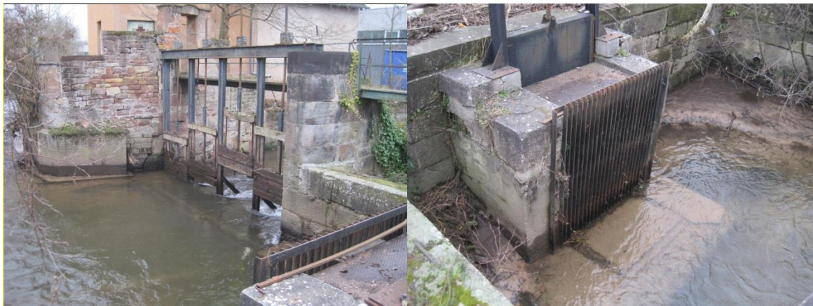
Fig. 8. Photos de l'ouvrage Amos (à gauche) et de la prise d'eau en rive droite (à droite) – (ARTELIA, Février 2016)
