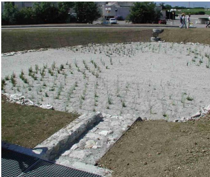
FIGURE 31 : FILTRE PLANTÉ DE ROSEAUX À NEYDENS TRAITEMENT DES EAUX PLUVIALES (SINT.FR)
