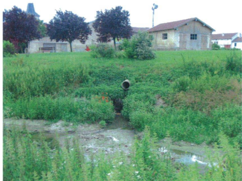
illustration n° 6: rejets non traités du village de Han dans le bras juste en amont du pont
