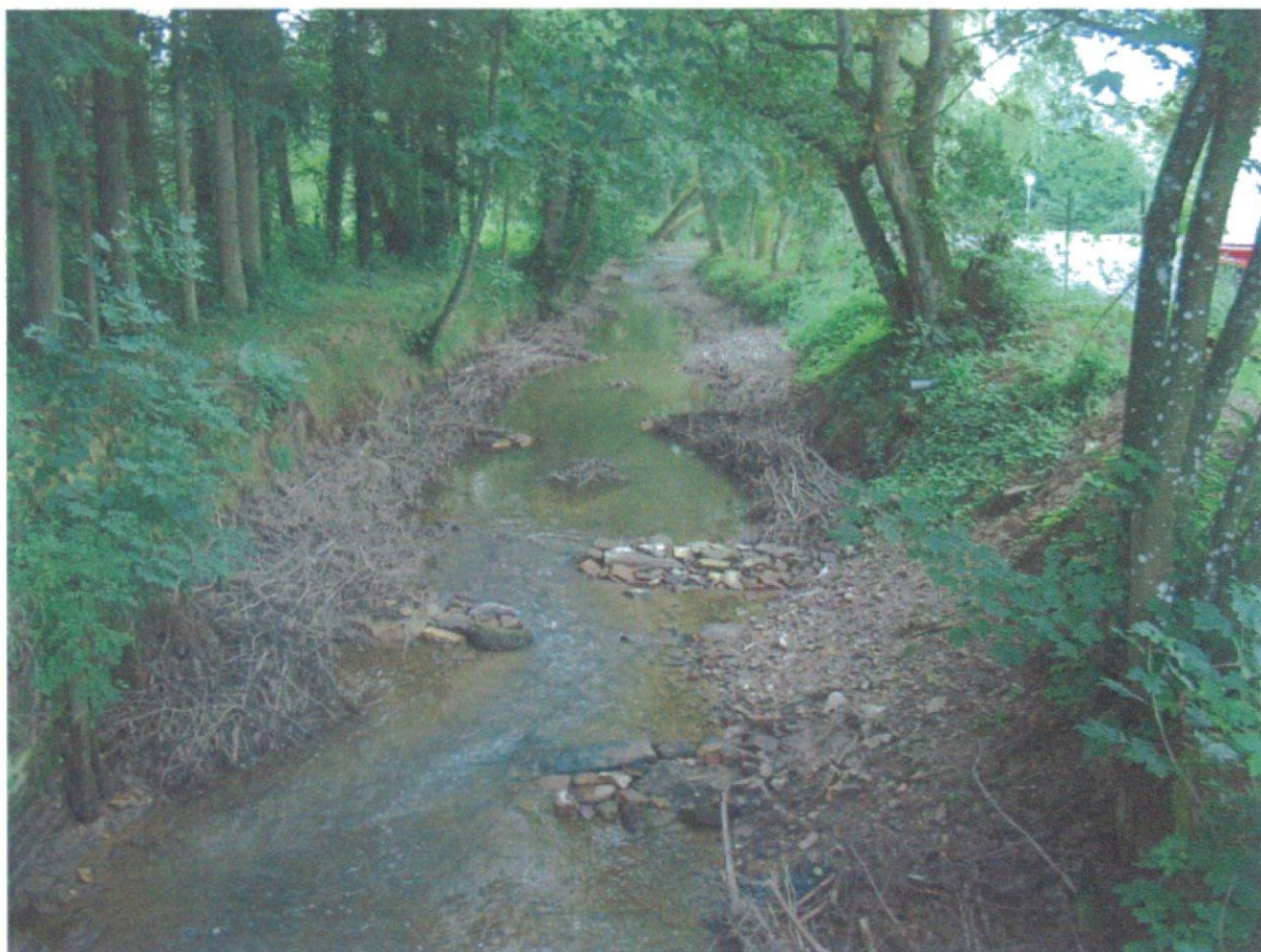
La Vence en amont direct de la vanne communale de Poix-Terron servant de réserve incendie
