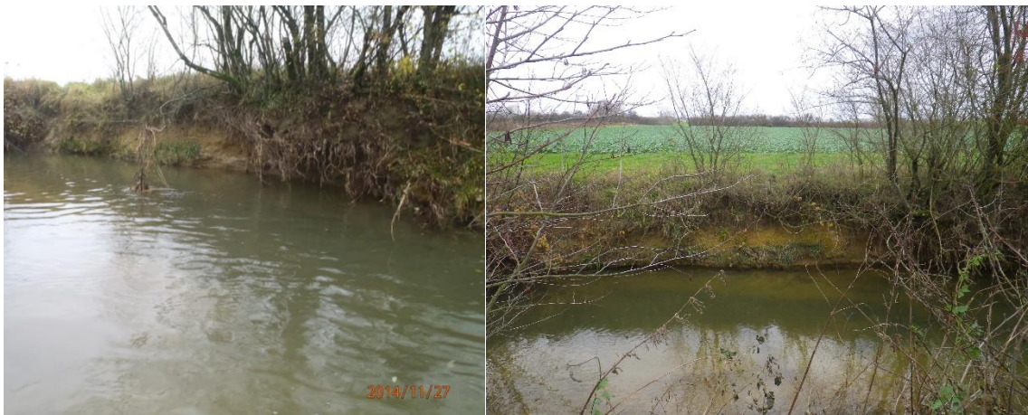
Photo 8 : Relative stabilité de la berge entre le 27/11/14 (à gauche) et le 02/12/2015 (à droite).
