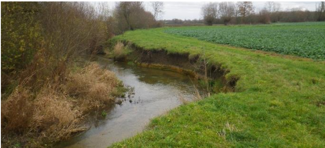
Photo 4 : malgré les apparences on a noté une relative stabilité de la berge entre le 2014 et 2015 sur cette encoche d'érosion du linéaire non restauré, au droit de l'annexe 8
