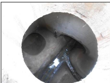
Figure 3-3 : Vue de la chambre du déversoir d’orage de la rue de l’Altenberg (Barr)
