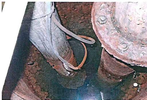
*Vue de l'avant puits - corrosion de la partie immergée*
