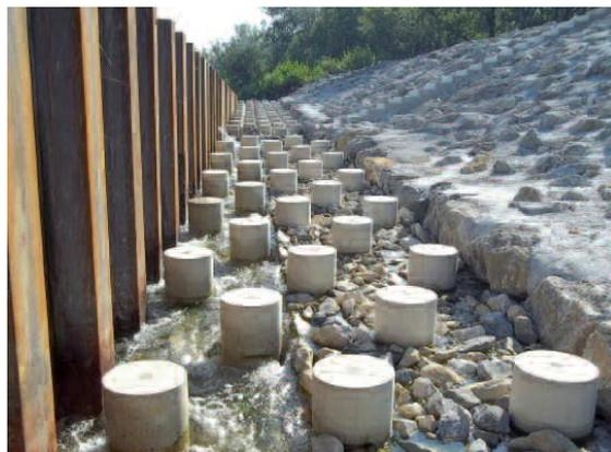
**Figure 48 : Rampe à macro-rugosités sur un seuil autoroutier de l'A7**
