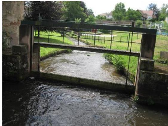
Figure 46 : Seuil aval et vanne de contrôle de la Piscine dans la fourchette des débits ciblés \_ 24/06/2015 – ( $Q_{\text{Weiler}} = 2.02\text{m}^3/\text{s}$  ; chute seuil  $\sim 25\text{cm}$ , chute vanne  $\sim 15\text{cm}$ )
