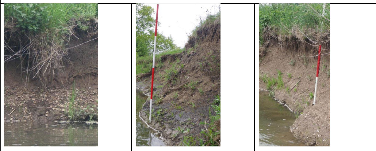
Les berges de la Mortagne sont en général caractérisées par une forte dominante argilo-limoneuse qui renforce leur stabilité, même si cela n'exclue pas la possibilité de lentilles graveleuses plus propices à l'érosion. Indice de cohésion moyen : 7
