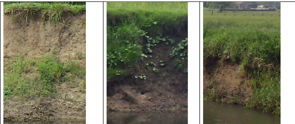
Talus de berge de la Vezouze à Chanteheux et Fréménil : matériaux argilo-limoneux cohésifs avec seulement de rares éléments plus grossiers. Indice de cohésion moyenne : 8
