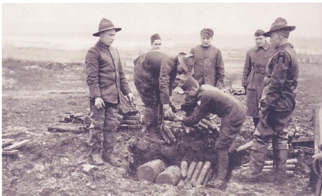
Figure 4 : Préparation d'un fourneau de pétardement par la Reclamation and Demolition Department, 1st Army. Jan. 13, 1919. Meuse (National Archives, Washington, USA).
