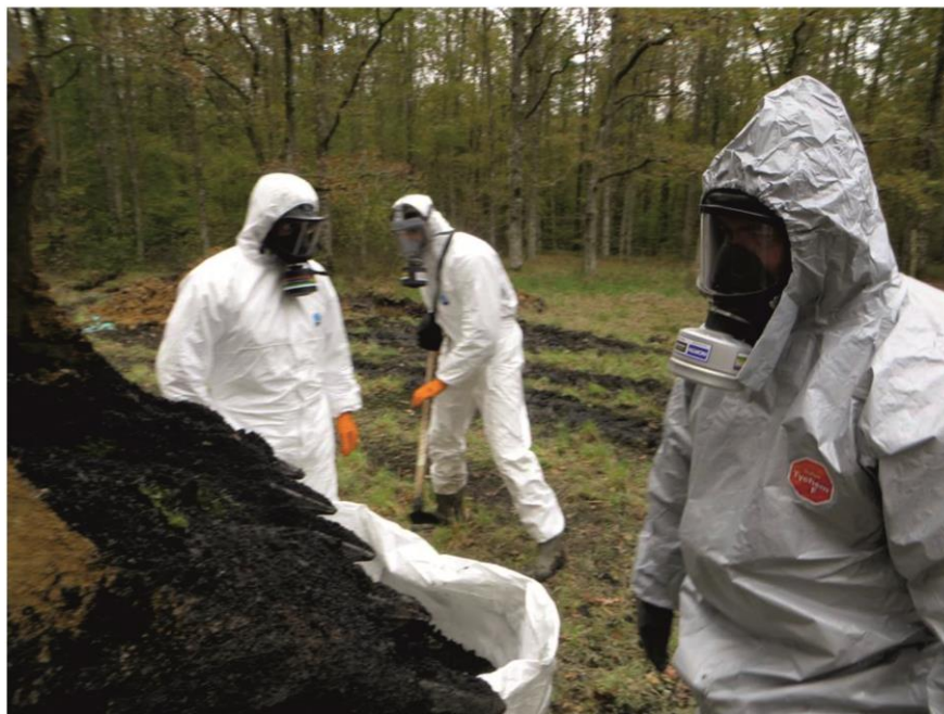
Figure 37 : Travaux de sondage à la pelle mécanique ; aperçu photographique.
