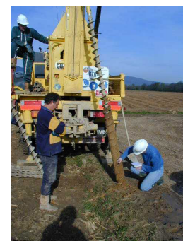
▲ Exemples de sondages à la tarière à main et à la moto-tarière réalisés dans le cadre de la BRAR.
