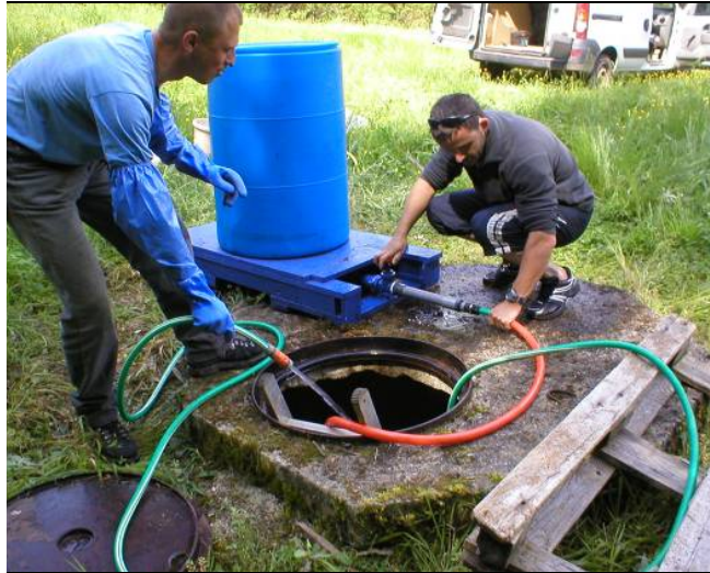
Figure 23 : Injection de l'iodure dans un puits sec (Photo GINGER)
