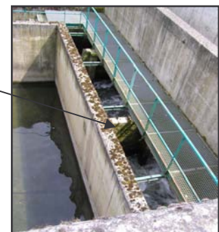
Figure 14 : exemple du seuil de Pierrepont sur la Crusnes
