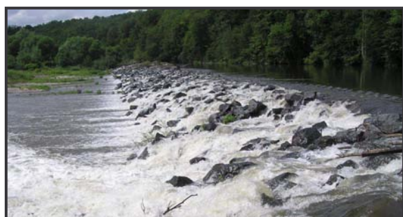
Figure 9 : Seuil en enrochement à Flavigny-sur-Moselle Source : FPPMA 54
