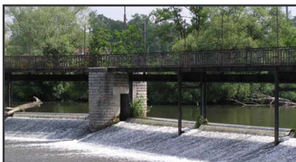
Figure 10 : Seuil bétonné à Damelevières sur la Meurthe Source : FPPMA 54
