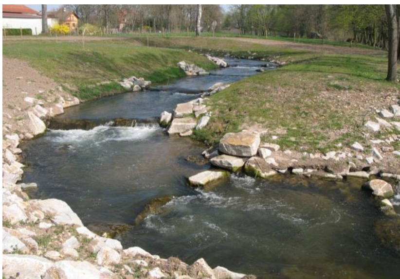
Fig. 15. Exemple de rivière de contournement (Barrage sur la Bruche à Avolsheim)
