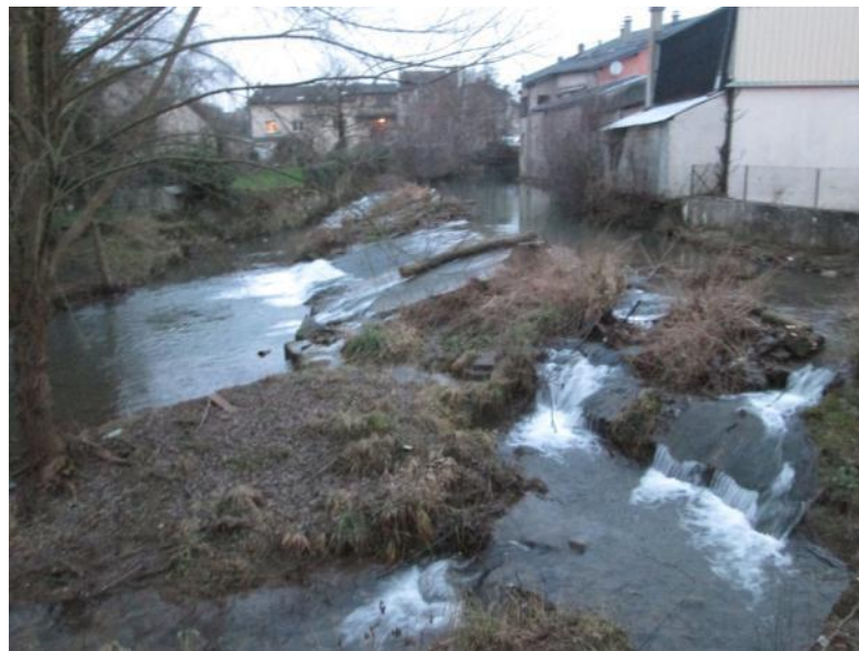
Fig. 17. Ouvrage ROE122, localisé au centre d'Hettange-Grande.
