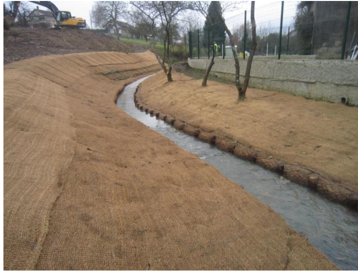
Fig. 20. Exemple de structuration d'un lit mineur d'étiage (Mutterbach à Farschviller 57)
