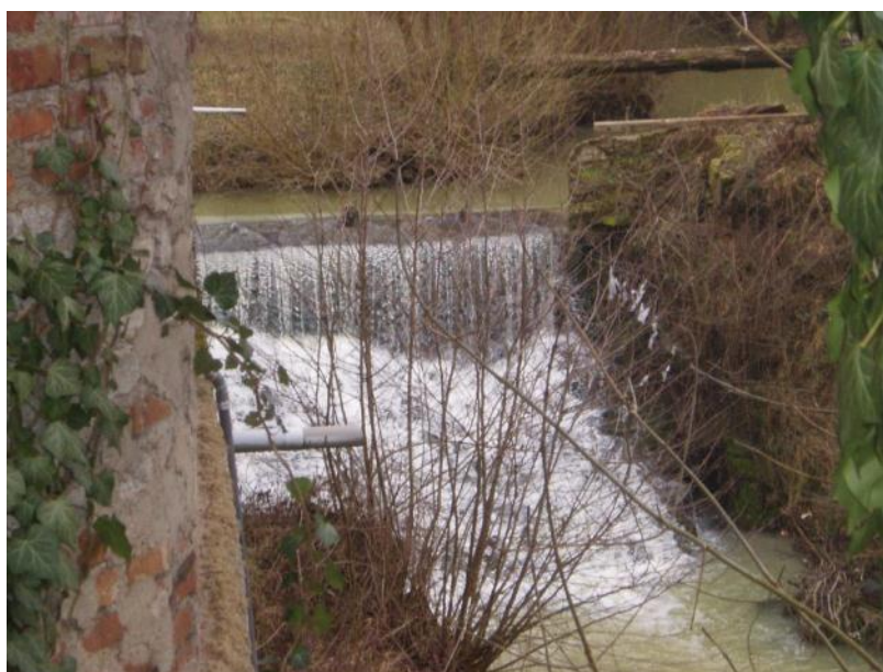
Fig. 24. Ouvrage ROE127, localisé sur la Kissel en amont de la confluence avec le Reybach (en aval de Soetrich).
