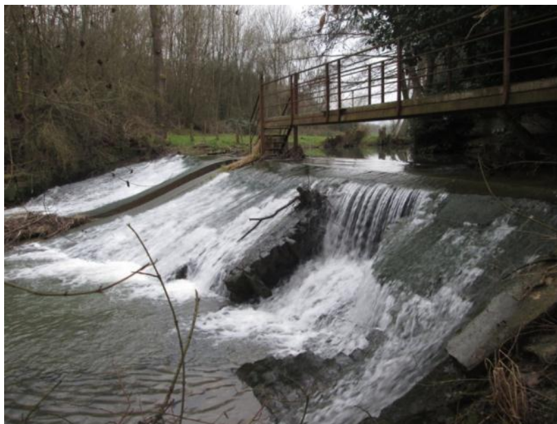
Fig. 29. Ouvrage ROE52395, localisé à l'enclave de Garche à Thionville.
