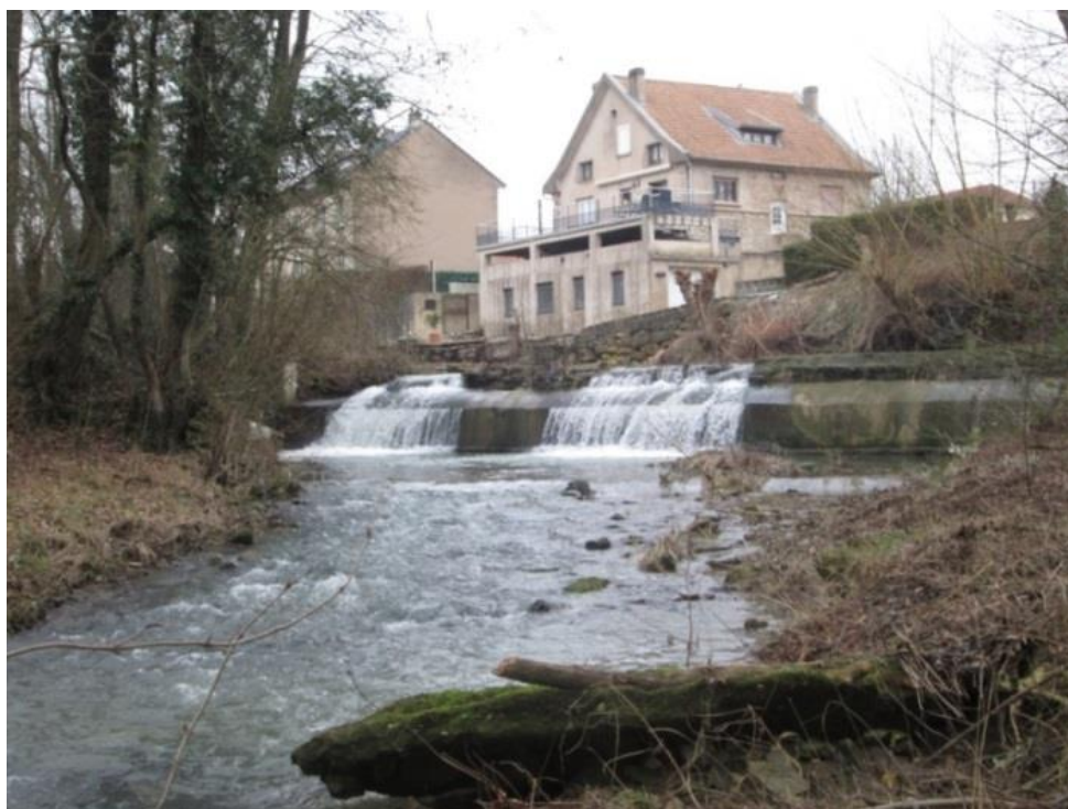
Fig. 14. Ouvrage ROE117, localisé au droit de la station d'épuration d'Hettange-Grande
