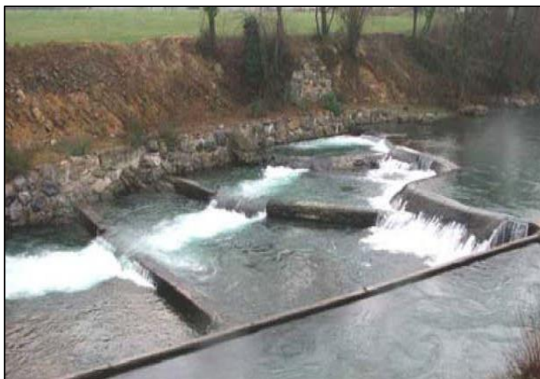
Fig. 32. exemple de pré-barrages sur le Gurmençon (64)
