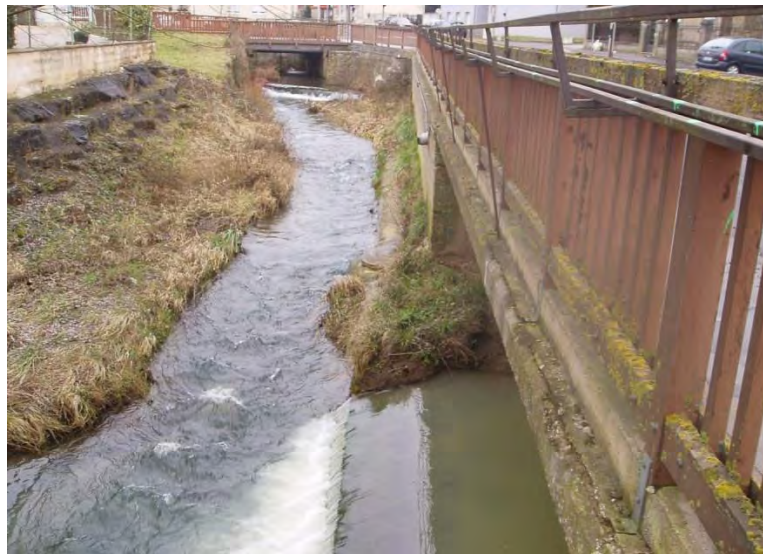
Fig. 79. Ouvrages au premier et à l'arrière plans au niveau de la confluence entre le Reybach et la Kissel.
