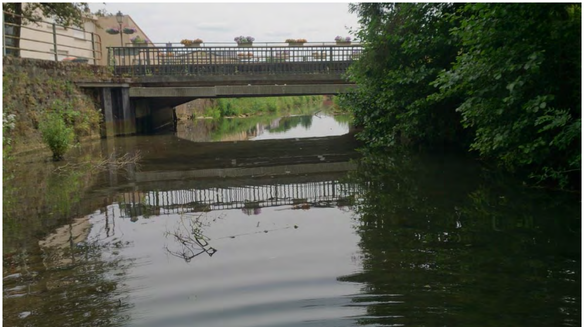
Fig. 21. Jaugeage à l'aval de l'ouvrage ROE122 au centre-ville d'Hettange-Grande
