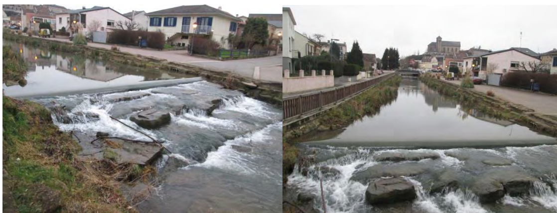
Fig. 78. Ouvrage ROE121 à l'amont de la passerelle en bois à l'aval du pont CD57 et lit contraint en amont
