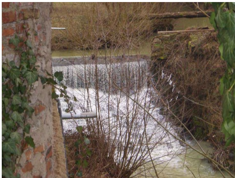
Fig. 8. Ouvrage ROE127, localisé sur la Kissel en amont de la confluence avec le Reybach (en aval de Soetrich).
