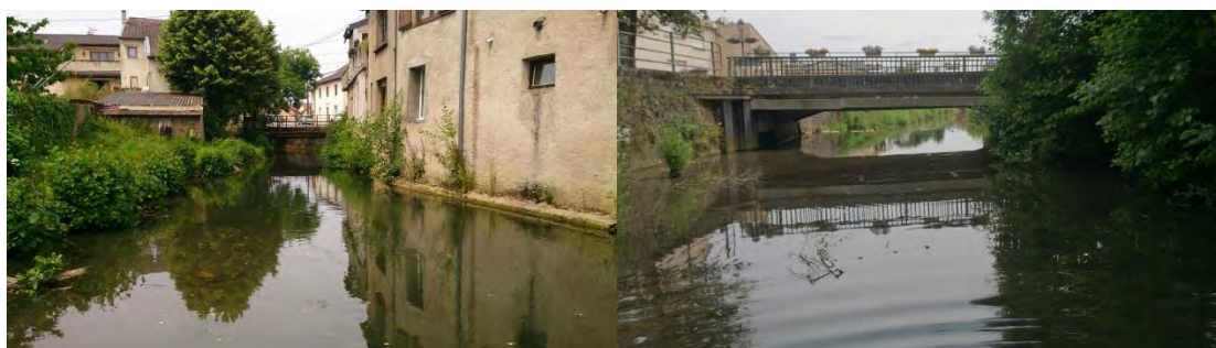
Fig. 67. Observations du tronçon amont (à gauche) et aval (à droite) au droit de l'ouvrage ROE122 (juin 2015)
