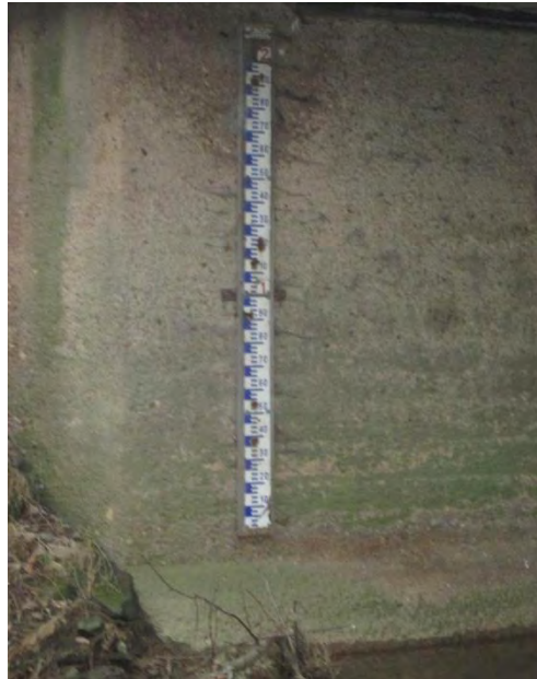
Fig. 17. Echelle limnimétrique sur le cours de la Kissel au droit du pont de la RN53
