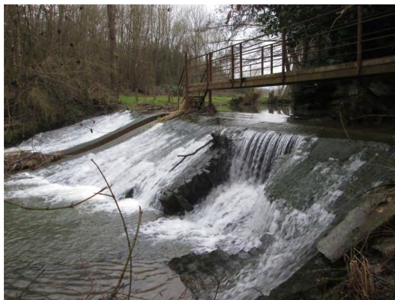
Fig. 9. Ouvrage ROE52395, localisé à l'enclave de Garche à Thionville.
