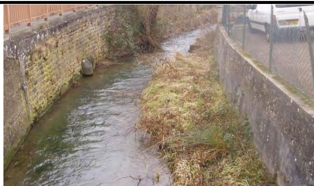
Amont de l'ouvrage
