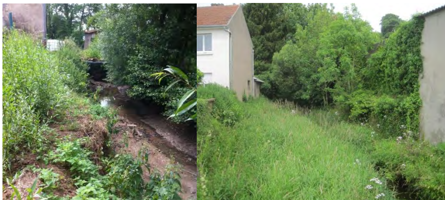
Fig. 66. Observations du tronçon amont (à gauche) et aval (à droite) au droit de l'ouvrage ROE127 (juin 2015)
