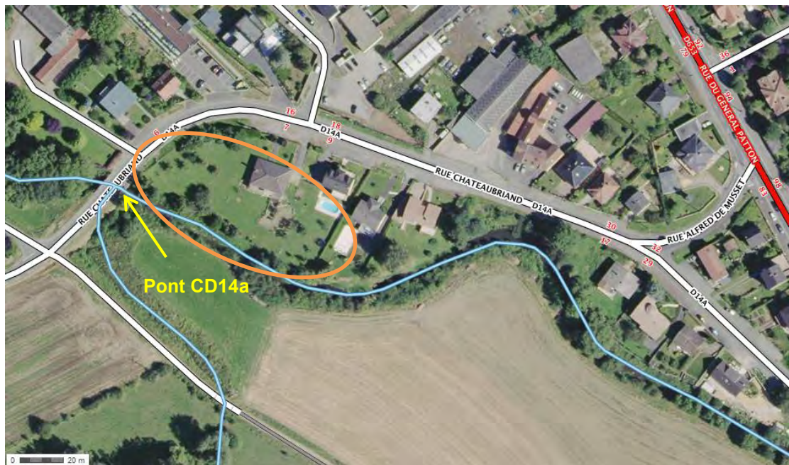
Fig. 81. Zone vulnérable aux inondations (orange) au niveau du pont CD14a.
