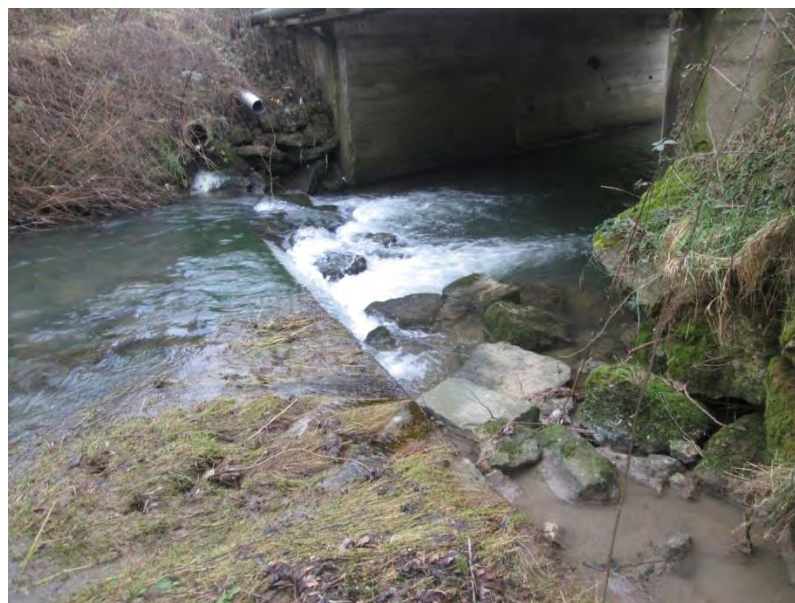
Fig. 80. Seuil au droit du pont CD14a en travers du lit mineur de la Kissel
