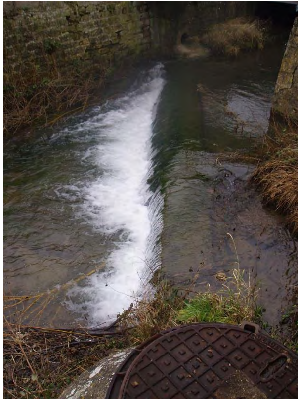
Fig. 14. Ouvrage (sans n°ROE) sur le Reybach, au droit du pont de la rue du Val.
