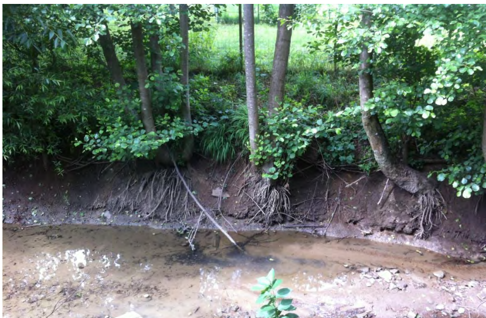
Fig. 37. Etat des berges à l'amont de l'ouvrage ROE127
