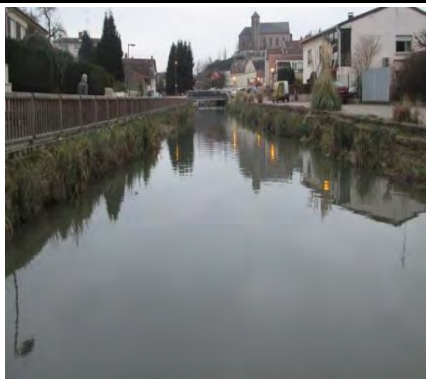
Amont de l'ouvrage
