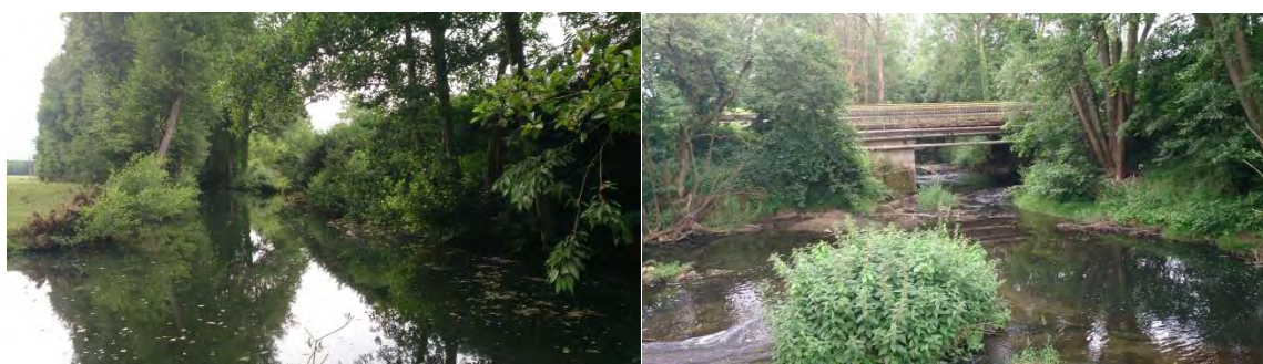
Fig. 69. Observations du tronçon amont (à gauche) et aval (à droite) au droit de l'ouvrage ROE52395 (juin 2015)
