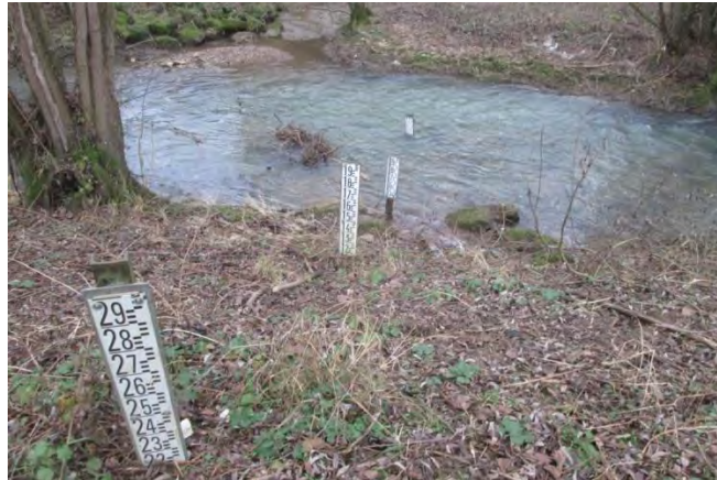
Fig. 15. Echelles limnimétriques au droit de la station d'épuration d'Hettange-Grande
