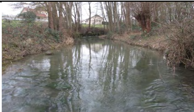
Amont de l'ouvrage
