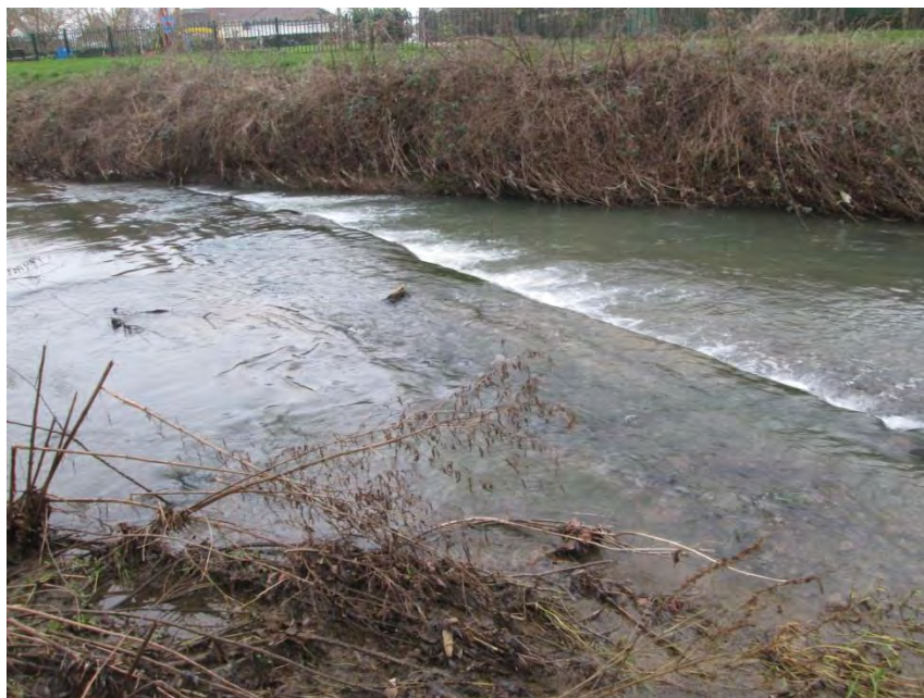
Fig. 13. Ouvrage ROE120, sur le tronçon de la Kissel entre la rue du Moulin et la rue Chateaubriand.
