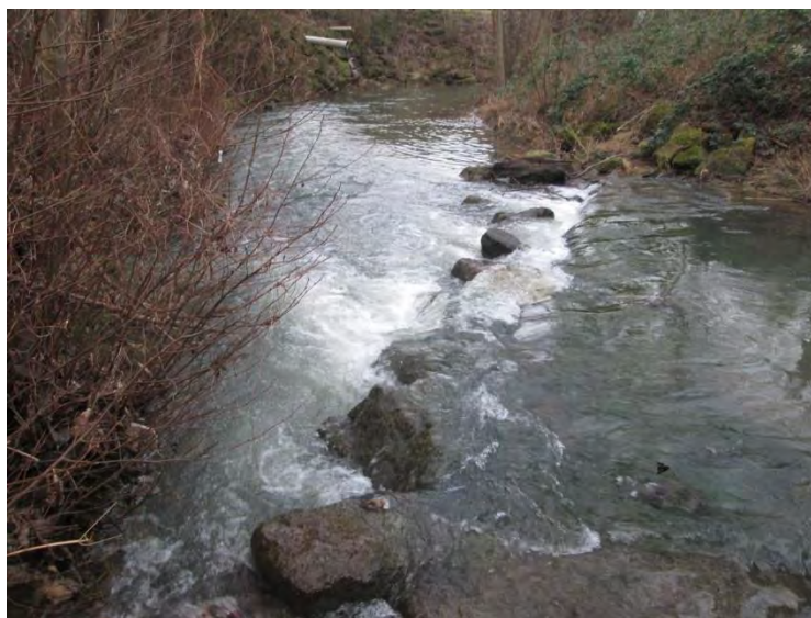
Fig. 11. Ouvrage ROE118, en aval du pont de la route D653.
