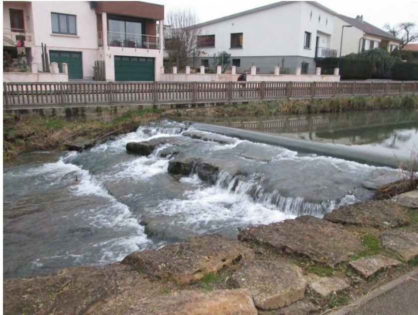
Fig. 12. Ouvrage ROE121, au centre d'Hettange-Grande.
