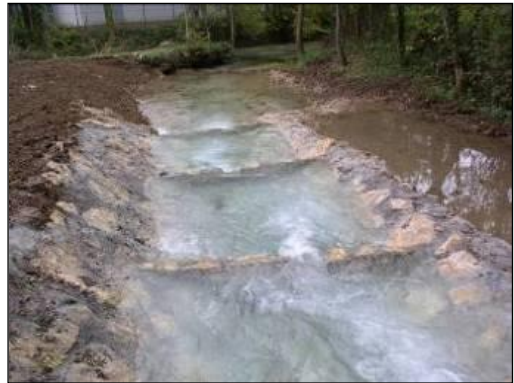
Exemple de réalisation de passes à poissons, réalisée à Thiaucourt sur le Rupt de Mad, sous maîtrise d'œuvre SINBIO.
