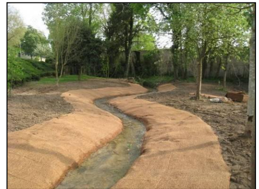
Aménagement du ruisseau de Montvaux sur le site de l'Agence de l'Eau Rhin Meuse en Moselle (57)
