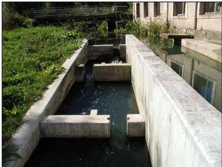
Exemple de réalisation de passes à poissons, réalisée à Thiaucourt sur le Rupt de Mad, sous maîtrise d'œuvre SINBIO.
