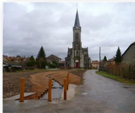
Etat après travaux (décembre 2013) : Ouverture du lit mineur, méandrage et végétalisation
