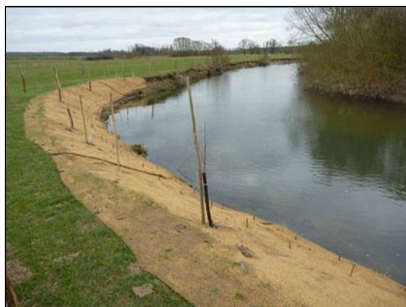
Travaux de végétalisation des berges sur la Mortagne (54)
