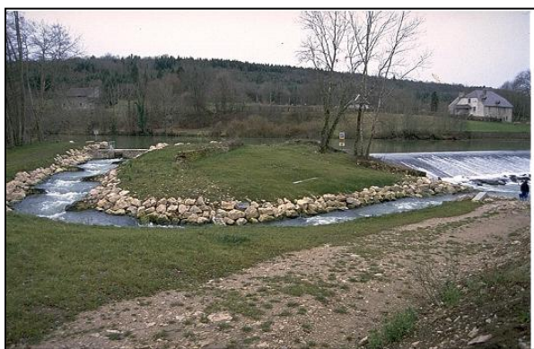
Exemple de Bras de contournement : Source : Guide technique pour la conception des passes naturelles (LARINIER, COURRET, GOMES, 2006).
