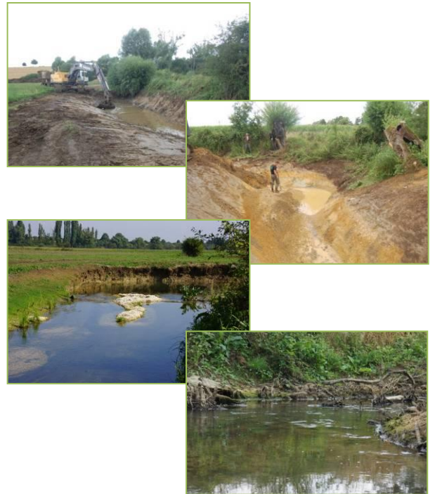
Exemple de projet de reméandrage sur le Longeau (54) et en phase travaux et 2 mois après travaux.
