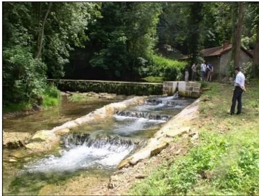
Exemple d'aménagement de seuils franchissables avec échancrure dans la traversée de Chatillon-sur-Seine sous maîtrise d'œuvre SINBIO
