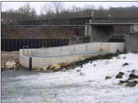
Exemple de réalisation de passes à poissons sur le barrage de Méréville, sous maîtrise d'œuvre SINBIO
