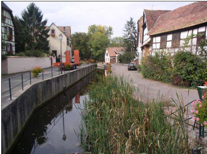
A gauche : milieu complètement uniformisé et banalisé par la présence d'un ouvrage hydraulique combiné à un lit sur calibré et des berges artificialisées entraînant un fort envasement dans le fond du lit avec une fermentation de ces dernières engendrant des odeurs nauséabondes et dégradant fortement la qualité d'eau.
