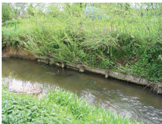
Photo 3 : Tunage et lit de saules sur le Traubach à Traubach-le-haut (LE BRETON, 2004).
