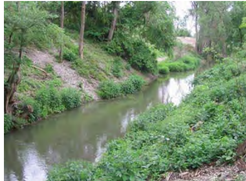
Photo 2 : Berges retalutées sur la Rigole de Widensolen à Wolfgantzen (LE BRETON, 2004).
