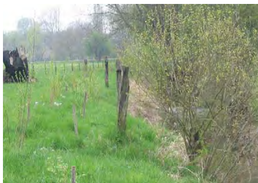
Photo 7 : Plantations sur la Vence à Montigny-sur-Vence (LE BRETON, 2004) pour maintenir les berges (problèmes amont).
