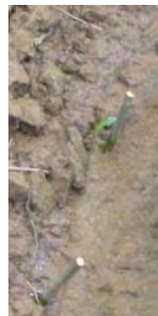
Photo 6 : : Plantations sur la Vence à La Francheville « Saint-Ponce » (LE BRETON, 2004) pour limiter l'encaissement du lit (problèmes aval).
