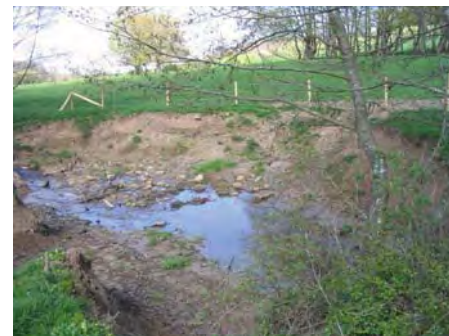
Photo 4 : Erosion due au piétinement par le bétail sur le Ruisseau de Romain aux Bois (LE BRETON, 2004).
