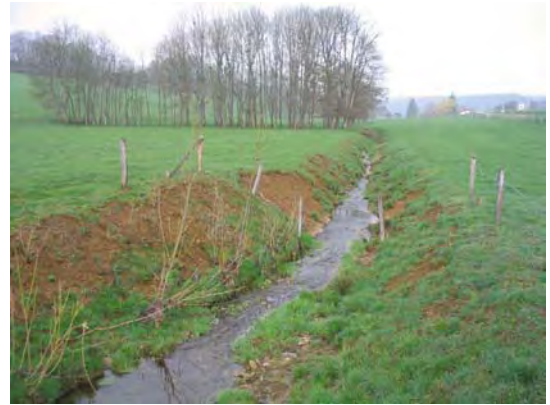
Photo 7 : Berge retalutée avec pose de géotextile sur l'Aroffe à Tramont-Emy (LE BRETON, 2004).
