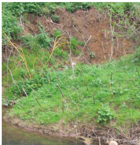
Photo 5 : Plantations sur la Vence à La Francheville « Saint-Ponce » (LE BRETON, 2004) pour limiter l'encaissement du lit (problèmes aval).
