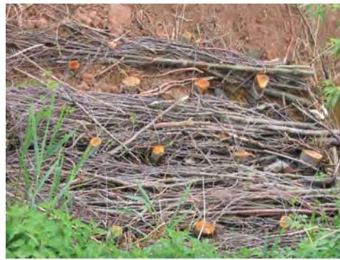
Figure 24 : Détail d'un des seuils en fagots réalisés sur la Schernetz à Epfig (LE BRETON, 2004).
