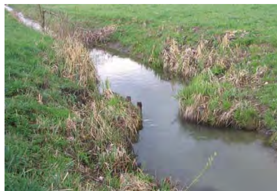
Photo 4 : Une des sinuosités créées sur le Saugraben à Bischwiller (LE BRETON, 2004).
