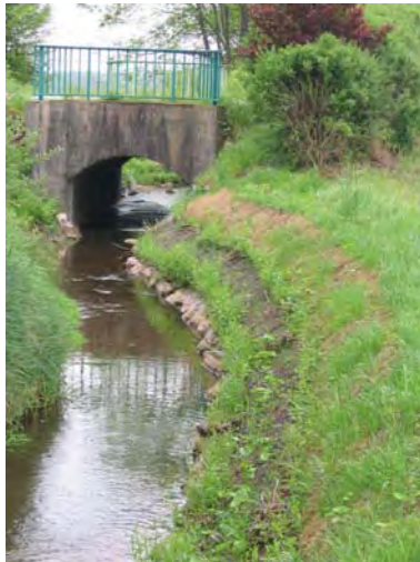
Figure 32 : Protection de berges liée à la présence d'un pont sur la Schernetz à Epfig (LE BRETON, 2004).
