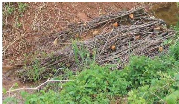
Photo 6 : Seuil en fagots sur la Schernetz à Epfig (LE BRETON, 2004).
