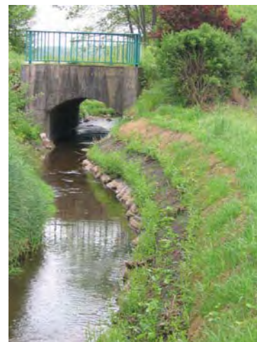
Photo 1 : Protection de berge liée à la présence d'un pont (LE BRETON, 2004).
