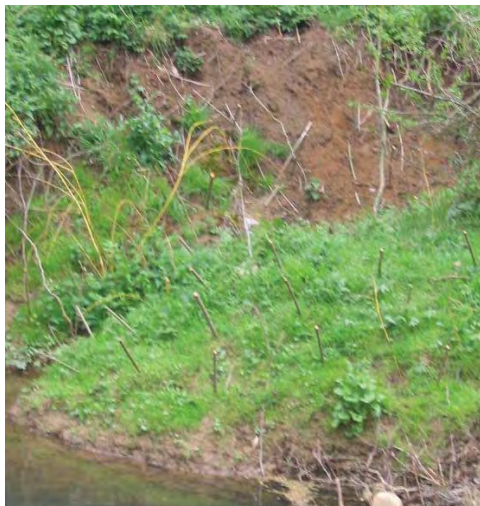
Figure 31 : plantations sur la Vence à La Francheville « Saint-Ponce » (LE BRETON, 2004) pour limiter l'encaissement du lit (problèmes aval).
