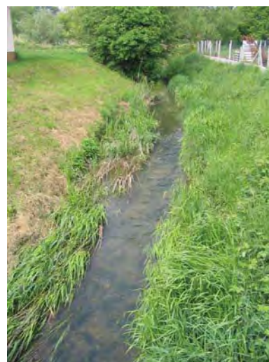
Photo 3 : Lit mineur recréé par banquettes végétalisées sur le Seltzbach à Kutzenhausen (LE BRETON, 2004).
