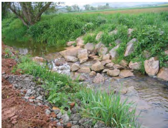
Photo 5 : Seuil en enrochement sur la Schernetz à Epfig (LE BRETON, 2004).
