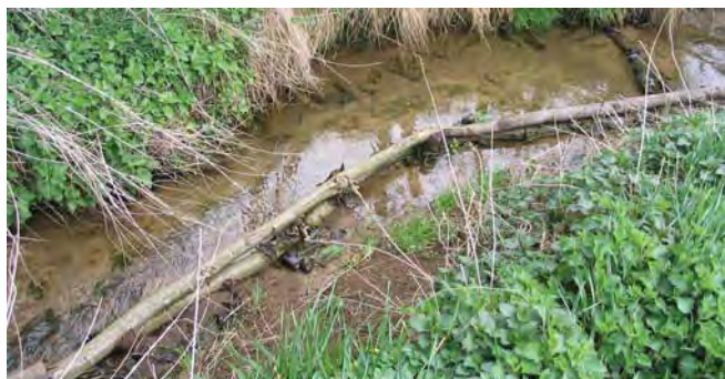
Photo 4 : Erosion derrière le tunage sur le Dorfgraben à Duntzenheim (LE BRETON, 2004).
