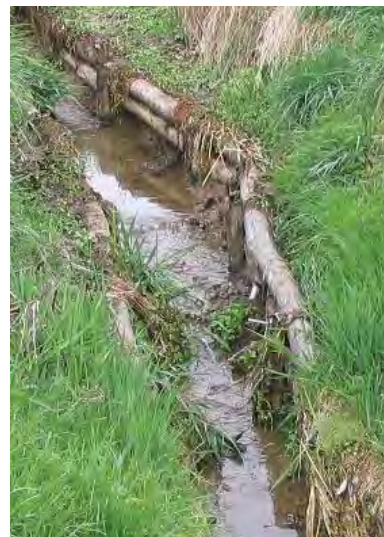
Photo 3 : Vue du tunage sur le Dorfgraben à Duntzenheim (LE BRETON, 2004).
