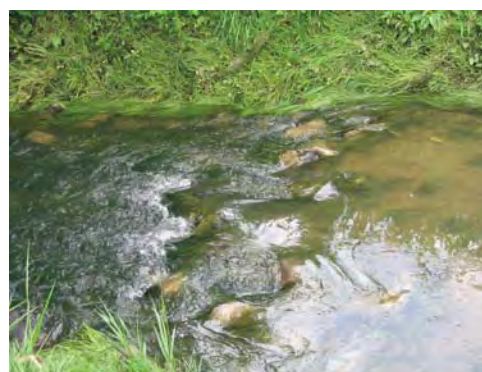
Figure 21 : Seuil en enrochement sur le Seltzbach à Kutzenhausen (LE BRETON, 2004).
