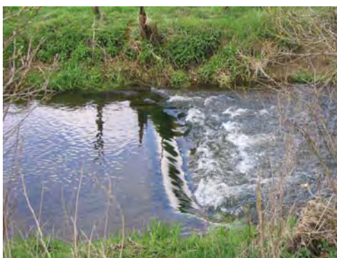
Figure 22 : Seuil sur l'Aroffe à Gibeauheim (LE BRETON, 2004).
