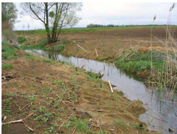
Figure 27 : Travaux en cours sur le Moutru à Saint Hilaire en Woëvre (LE BRETON, 2004).
