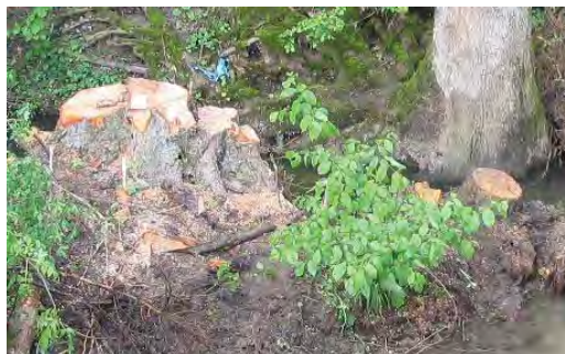
Photo 2: Ouverture de la végétation par tronçonnage sur le Soultzbach à Soppe-le-haut (LE BRETON, 2004).
