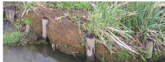
Photo 1 : Banquettes d'hélophytes sur le Saugraben à Bischwiller (LE BRETON, 2004).
