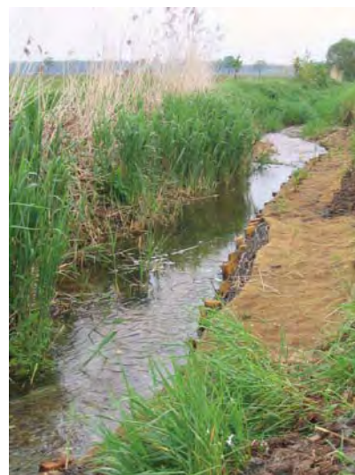
Photo 7 : Banquettes d'hélophytes sur la Schernetz à Epfig (LE BRETON, 2004).
