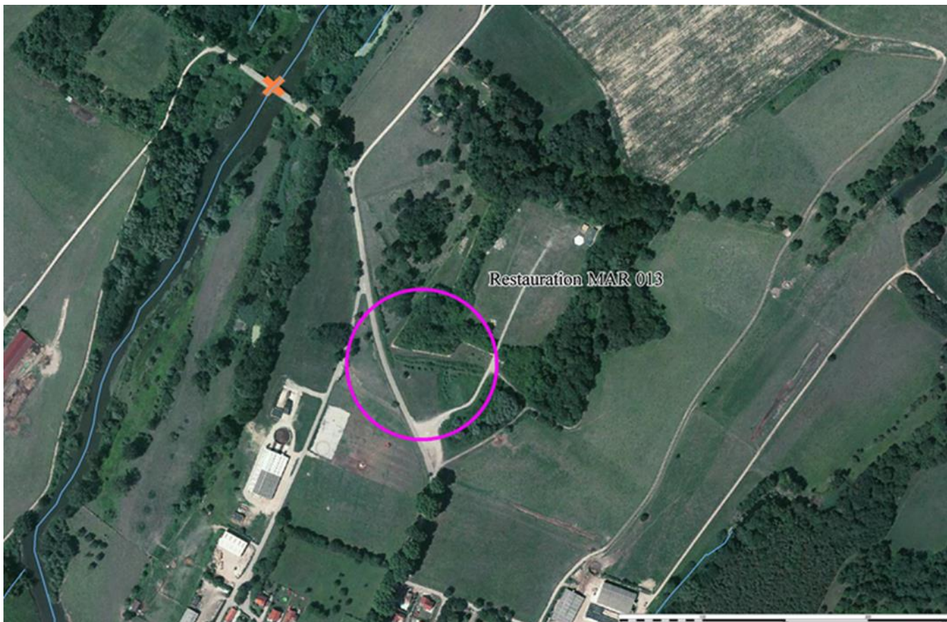
Figure 30 : Restauration e MAR 013 à FORT-LOUIS
