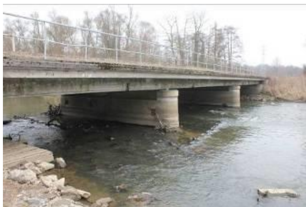
Ouvrage N°3 : Pont SNCF
