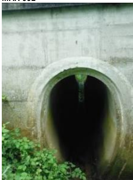
OUV 004 passage sous ligne SNCF
