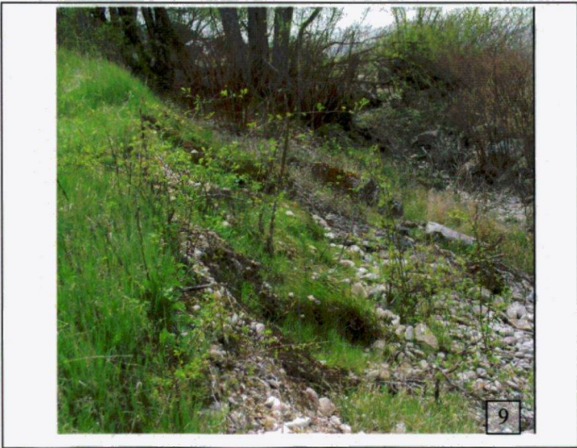
Berge de la Moselle le 14 avril 2005 Vue sur un détail de la digue de la Moselle en amont du barrage : les grillages des gabions sont encore visibles par endroits
