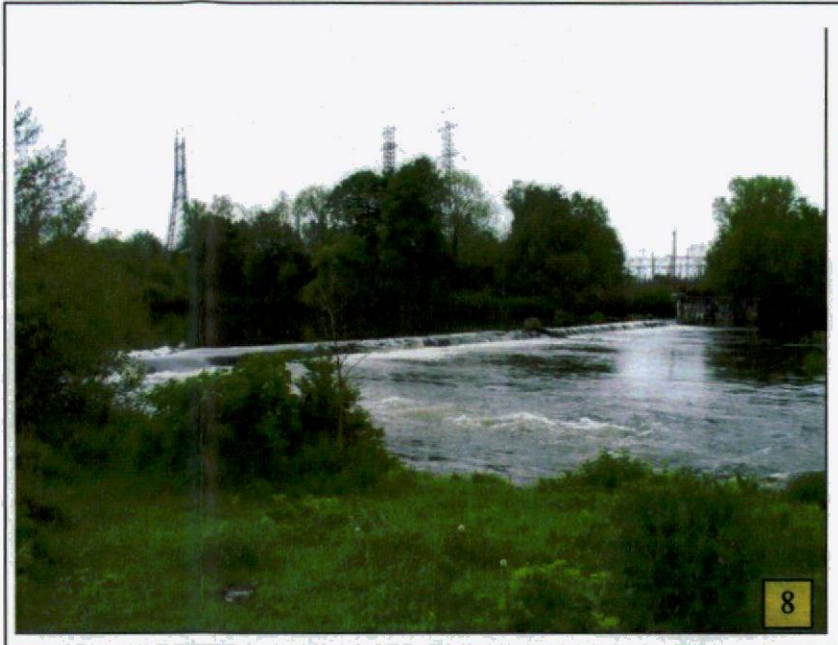
Le barrage de Langley le 16/05/05 Le barrage montre des signes d'érosion, mais joue encore son rôle de maintien de la ligne d'eau et de stabilisation du fond.
