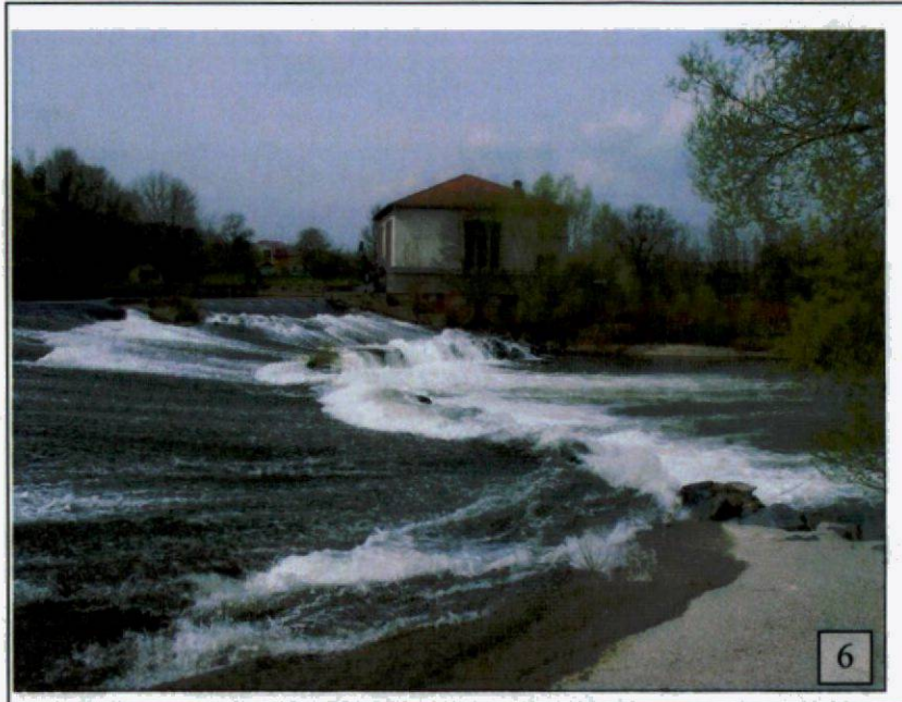
Le barrage de Charmes le 14/04/05 L'affouillement du parement aval, lié à l'incision du lit de la Moselle en aval, est très visible
