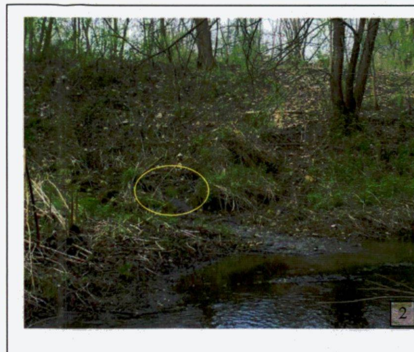
L'écoulement à travers la digue le 14/04/05
