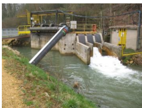
Galerie des Eaux à Knutange
