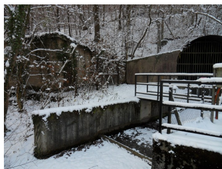
Exutoire de la galerie de Bois d'Avril
