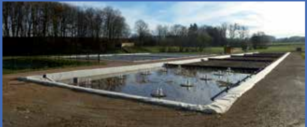
La mise en service du filtre planté de roseaux à Pfetterhouse en 2014, un exemple d'action qui participe à l'amélioration de la qualité des eaux de la Largue
