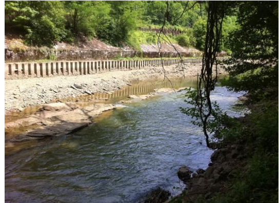
A gauche, vue d'un plat lent en amont de la première grande zone de radiers, puis vue d'un plat courant au droit du secteur où la voie ferrée borde le lit : un rideau de palplanche protège l'ensemble.
