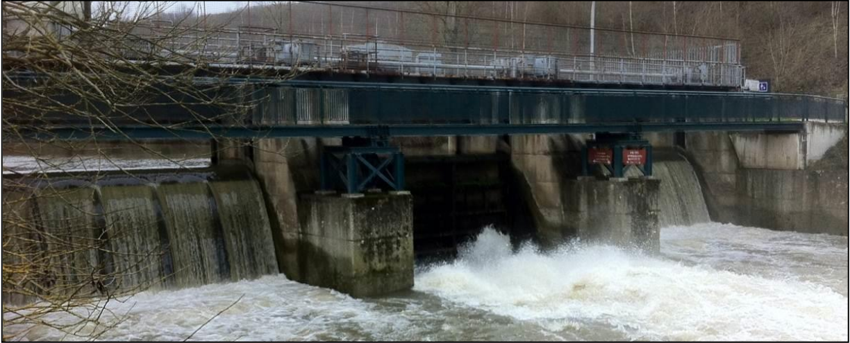
Vue d'aval pendant la levée partielle de la vanne centrale.
