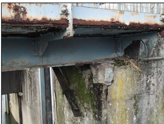
Détails de désordres au niveau des jonctions béton – métal – mortier.
