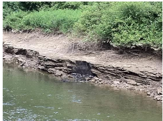
En amont du secteur protégé en rive droite par des palplanches, vue d'un plat courant avec en berge, un horizon stratifié instable, dont quelques éléments ont localement glissé suite à l'abaissement (à droite). Cette configuration est observée sur environ 150 ml. En partie supérieure, la berge possède un replat végétalisé stable, avant le talus principal boisé en haut duquel se trouve la voie ferrée. On remarquera une des nombreuses places de pêche aménagées par les riverains, en rive gauche.
