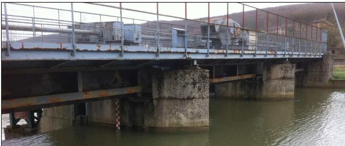
Vue d'amont de l'ensemble piles + portique avec batardeaux.
