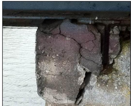
Détails de désordres au niveau des jonctions béton – métal – mortier.
